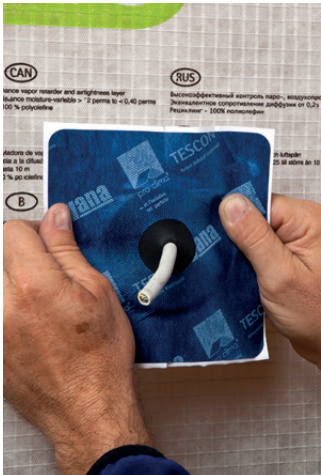
13. Tilslutning omkring ledninger og rør KAFLEX hhv. ROFLEX pakninger føres henover kablet eller røret og påklæbes Intello-banen. Kabelpakningerne er selvklæbende, rørpakninger påklæbes banen med TESCON VANA.
