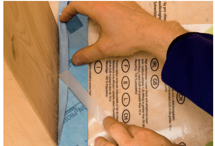
14. Tilslutning i hjørner Præ-foldet vinkeltilslutningsbånd TESCON PROFECT placeres i hjørnet på folien, hvorpå den første side påklæbes. Fjern derefter folien og påklæb den næste side.
