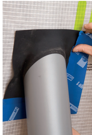
13. Tilslutning omkring ledninger og rør KAFLEX hhv. ROFLEX pakninger føres henover kablet eller røret og påklæbes Intello-banen. Kabelpakningerne er selvklæbende, rørpakninger påklæbes banen med TESCON VANA.
