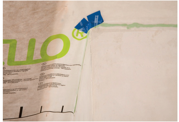
12a. Tilslutning til fuldpartlet skorsten (isoleret eller med hulrum) Derefter skæres mindre stykker TESCON VANA ind til stykkets midte, tilpasses hjørnet og påklæbes.
