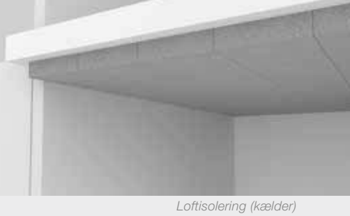
Loftisolering (kælder)
