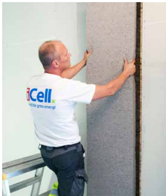
iCell-skiven er nem at anvende og skaber meget lidt støv.
